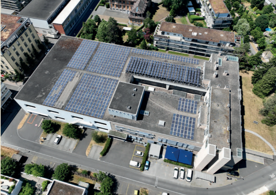
Umbauarbeiten Stiftung Faro in Windisch – Bauleitung: ONE24 Holding AG.
