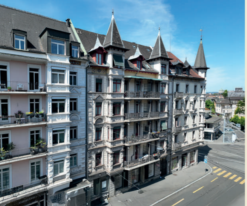
Umbauarbeiten komplettes Gebäude 2026 – Architekt: ONE24 Architektur GmbH.
