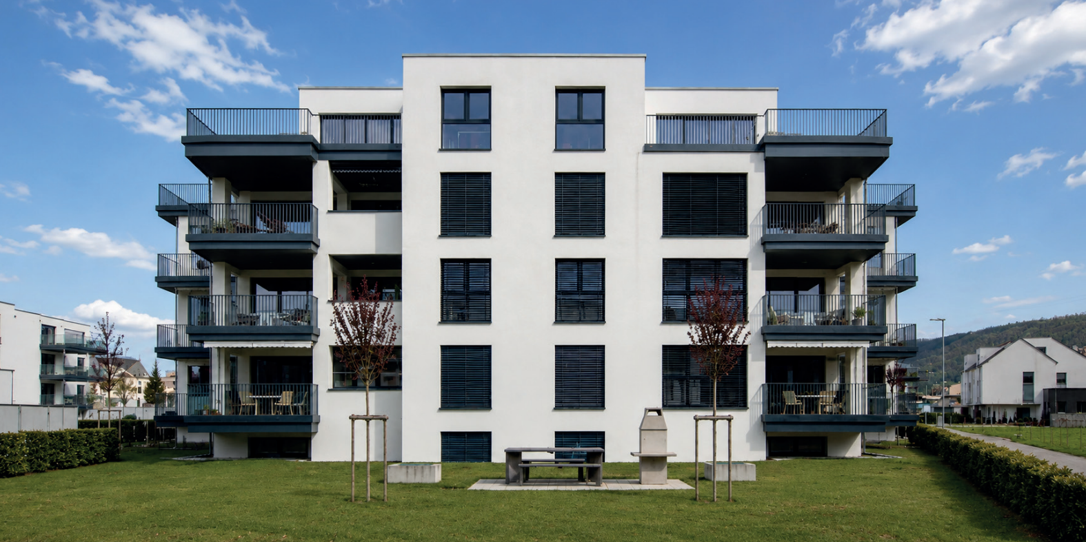
Gebäudesanierung Fassade / Balkone / Abdichtung in Weiach 2026
