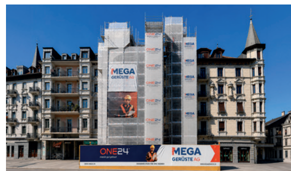
Sanierung Denkmalschutz Asylstrasse in Zürich
